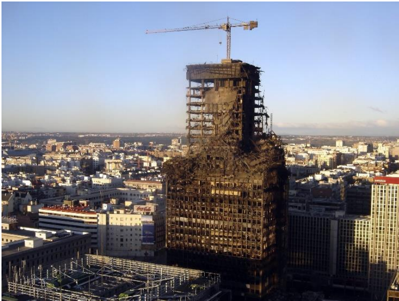
Abbildung 5: Windsor Tower in Madrid, nachdem er fast 24 Stunden gebrannt hat (2005)
