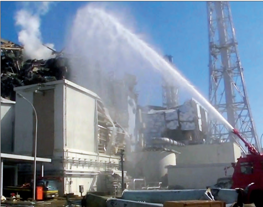
12. März 2011: Das Atomkraftwerk Fukushima wird von einer Tsunami-Flutwelle zerstört.
