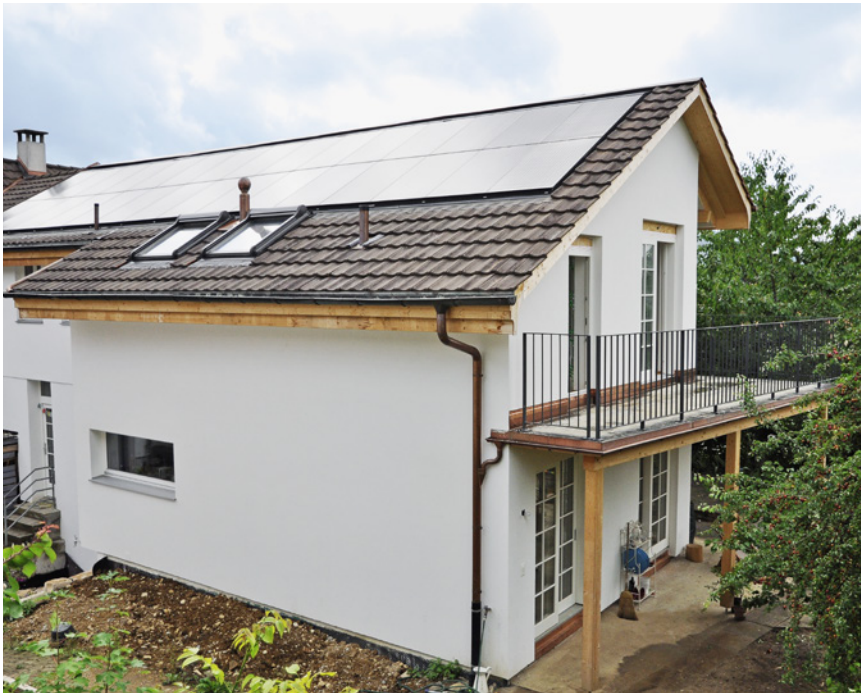
Das Haus als Kraftwerk: Ostseite mit PV-Panels.
